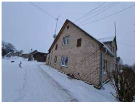
Dzīvojamā māja Stacijas ielā 66
