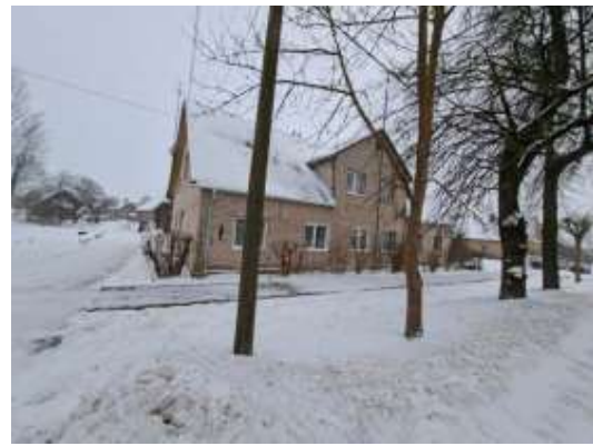
Dzīvojamā māja Stacijas ielā 66
