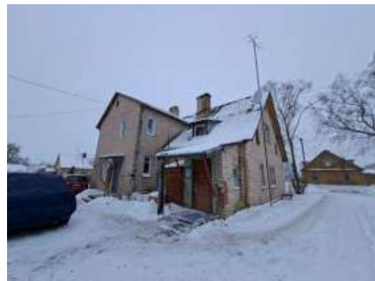
Dzīvojamā māja Stacijas ielā 66
