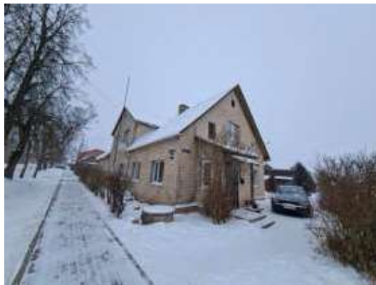
Dzīvojamā māja Stacijas ielā 66
